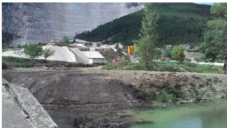
Stato dei lavori in sponda sinistra subito a valle del canale di derivazione – ottobre 2015
