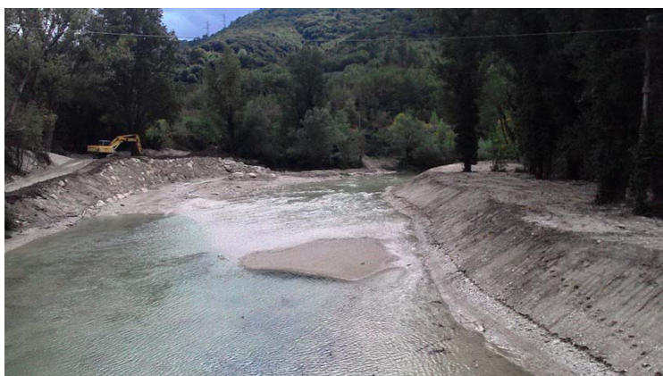
Stato dei lavori sponda destra e sinistra– ottobre 2015
